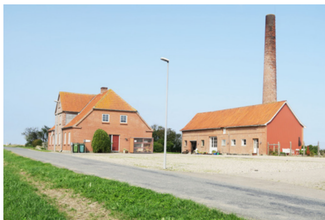
Mejeriets hovedbygning er nedrevet, men den resterende del fremstår intakt
